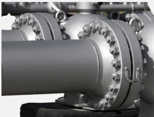
Рисунок 1 – Использование резьбовых соединений в трубопроводах
